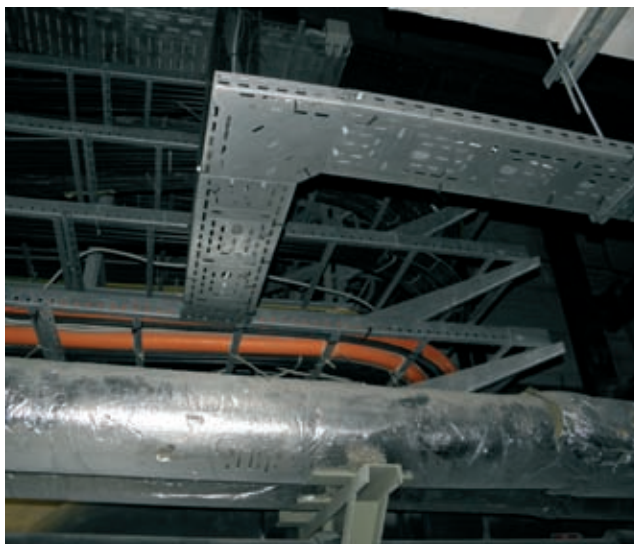
Rys. 3. Korytka i drabinki kablowe, trasy kablowe
